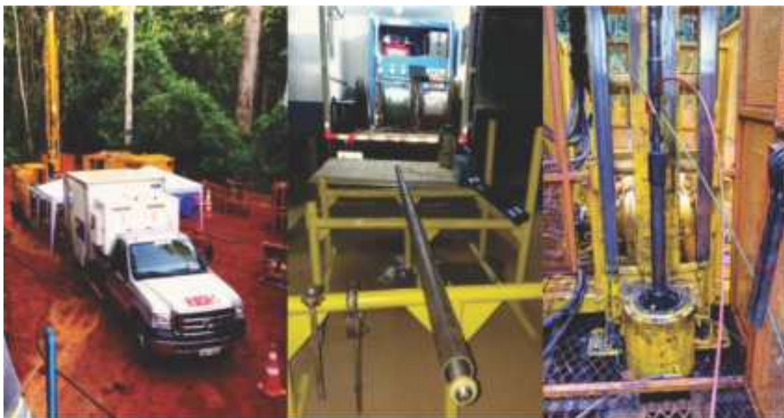
Figura 5.5 Equipamento de FH para dos ensaios no diâmetro N até a profundidade de 800 m. No mosaico de fotos temos o veículo 4x4 modelo baú que abriga a máquina de fraturamento hidráulico seguida de uma visão geral da máquina de fraturamento operando no momento em que o obturador duplo está na bancada realizando testes de superfície e por fim o obturador em montagem para iniciar a descida em furo de sondagem que será ensaiado.
