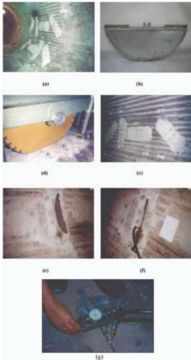
Figura 7.1 Sequência mostrando as etapas do método das almofadas; a) geratrizes da galeria circular preparadas; b) almofada plana com flecha de 24 cm; c) pinos de referência fixados e leitura inicial efetuada; d) início da abertura da fenda; e) inserção da almofada; f) pressurização da almofada e g) medida da neutralização dos deslocamentos.
